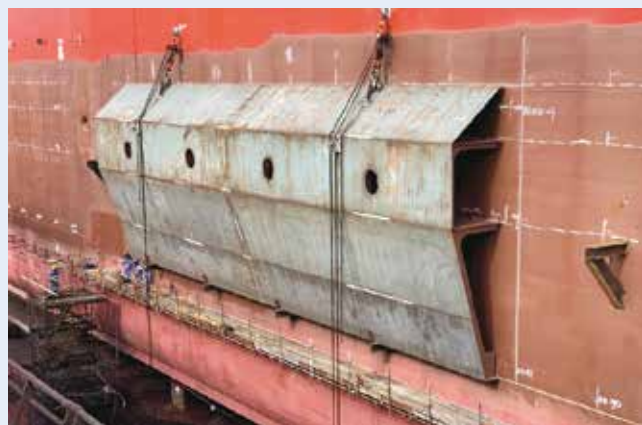
SLIKA 2. Montiranje dijela ojačanja
