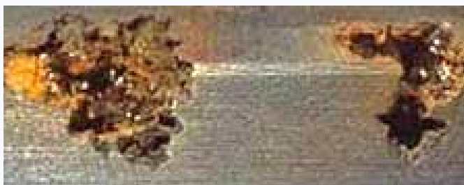
Slika 5 - Erozijski oštećenja stijenki cilindra uzrokovana kavitacijom
