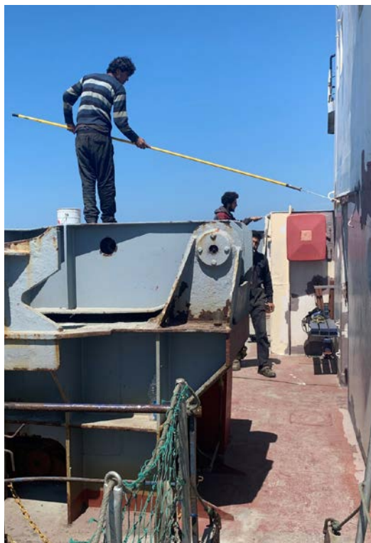
Posada otklanja nedostatke nađene pri inspekciji, ali i dalje nema sigurnosne opreme
