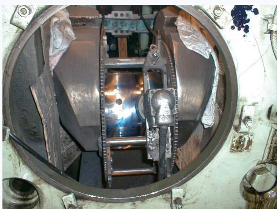
Slika 7 - montirana naprava na osovini glavnog motora spremna za početak brušenja osnjaka osovine. (Naprava je izrađena u firmi Goltens Marine i podesna je za različite promjere osovina.)
